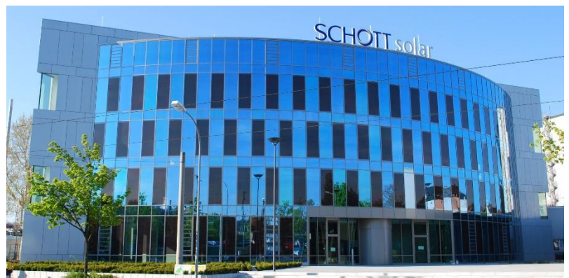
5 - Außenansicht fertiges Gebäude
