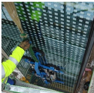
2 - Einbau der Scheiben vor Ort
