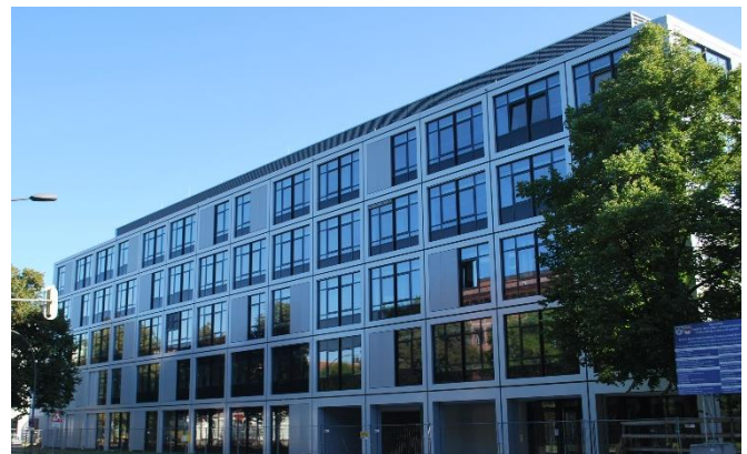
5 - fertige Fassade Ansicht Luitpoldstraße
