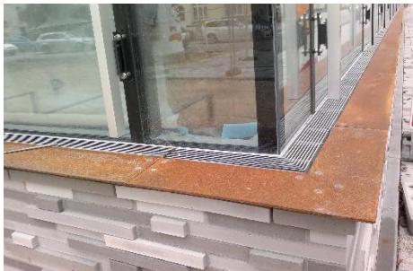
3 - unterer Anschluss Fassade
