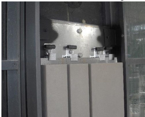
2 - Detail Befestigung Keramikplatten
