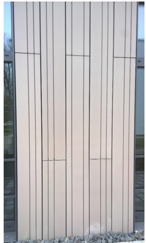
5 - Fugenverlauf Keramikplatten EG
