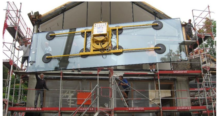
2 - Einbau Panoramasscheibe mit Spezialvakuumsauggerät
